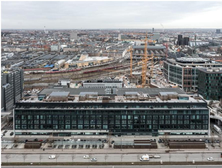
Den 180 meter lange facade set fra Kalvebod Brygge. Fotograf: Rasmus Hjortshøj
